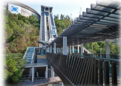
Elevador Inclinado da Colina da Taipa Grande
